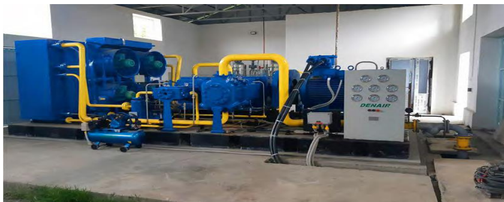
Рисунок – 2. Возвратно-поступательный поршневой компрессор.
