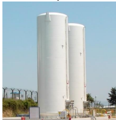
Криогенная емкость для хранения СПГ.
